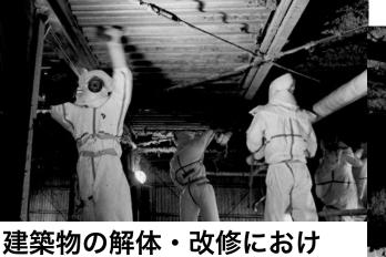
建築物の解体・改修におけ るアスベストの適正処理
